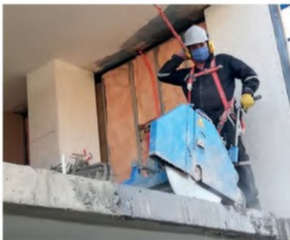
Der Elektro-Fugenschneider KDF800-E im Einsatz auf einer Baustelle in Chile.
