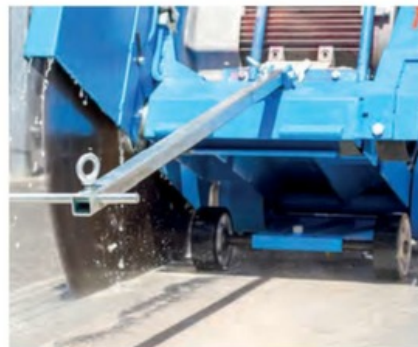
Der Elektro-Fugenschneider KDF800-E im Einsatz auf einer Baustelle in Chile.
